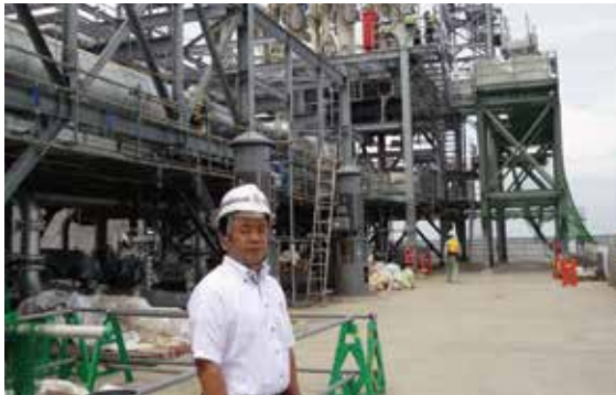
石狩市、天然ガス発電プラントを調査した。
