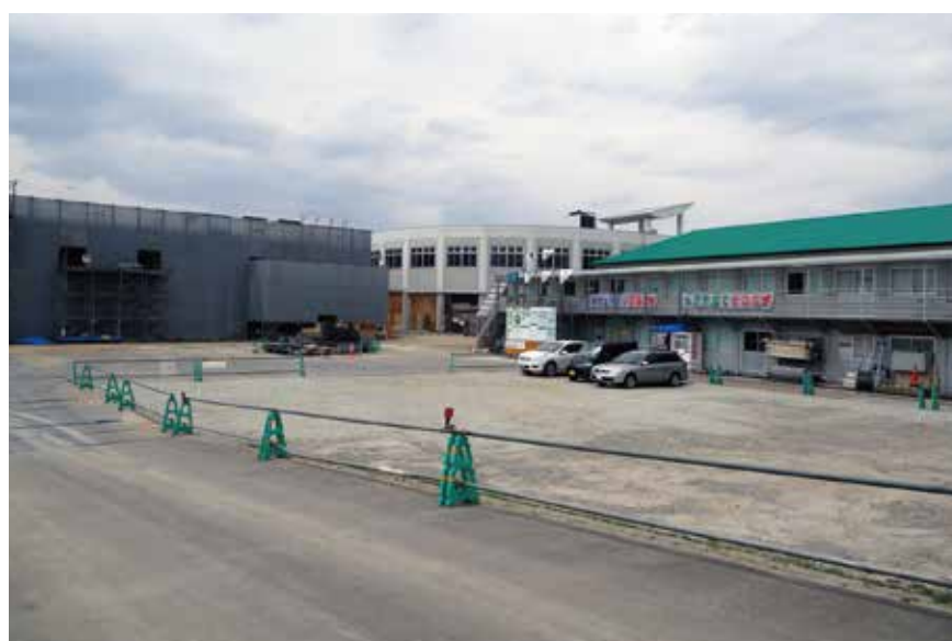
「米沢栄養大学」の校舎建築が急ピッチで進んでいる。
